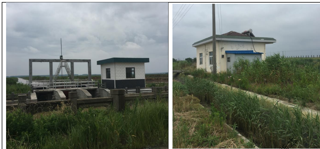
图 4.2-2 南片区泵站及斗渠现场情况
