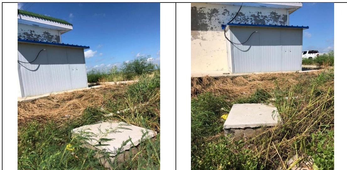
图 7.3-1 化粪池建设情况
