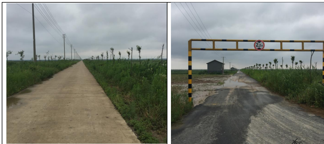
图 4.2-1 北片区道路、斗渠、生产用房绿化情况
